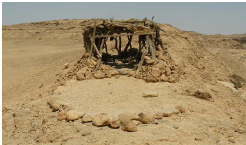
Figure 16. A shepherd's house built on a ridge above a cattle shed. It consists of two parts: a covered one and an open one. Both parts are oval in shape and made of stone laid in dry stone [Чобанска кућа саграђен на гребену изнад обора за стоку. Састоји се из два дела: покривеног и отвореног. Оба дела су овалног облика формирана од камена сложеног у сувозиду]
