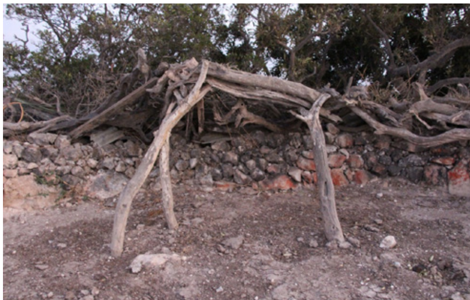
Figure 39. Remains of the roof structure: columns, beam and part of the massive branches instead of rafters [Остаци кровне конструкције: ступци, греда и део масивних грана уместо рогова]
