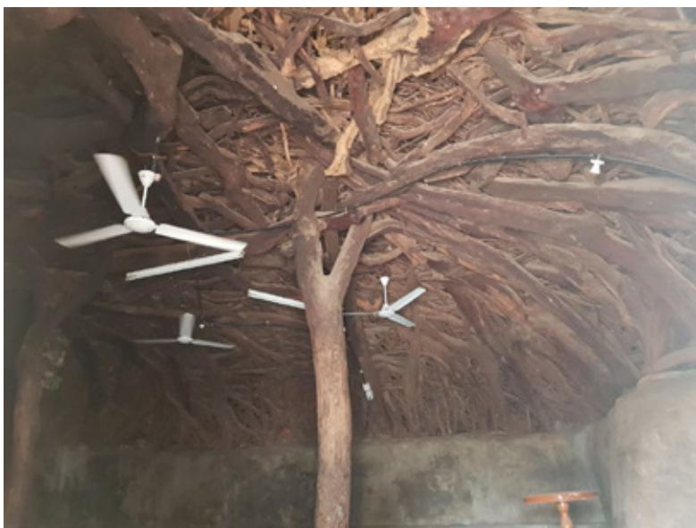
Figure 54. Central columns, cross beam, and roof structure resting on a stone wall (plastered) [Централни ступци, попречна греда, и кровна конструкција која се ослања на камени зид (омалтерисан)]
