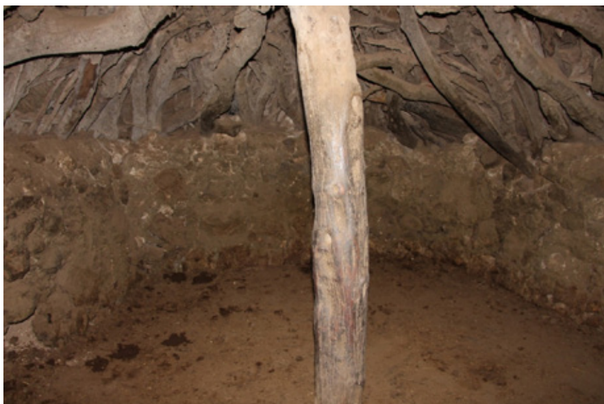
Figure 57. Column, part of the roof structure and stone wall [Стубац, део кровне конструкције и камени зид]
