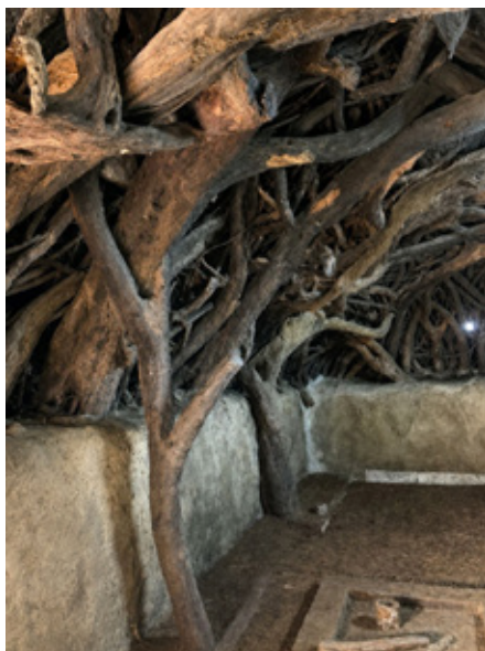
Figure 43. Part of a plastered stone wall and a roof structure directly next to the wall [Део омалтерисаног каменог зида и кровна конструкција непосредно уз зид]
