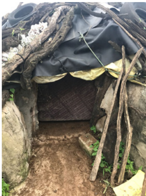
Figure 51. Entrance door, next to a stone wall (plastered), and part of the old and new roof covering [Улазна врата, део каменог зида (омалтерисан), и део старог и новог кровног покривача]
