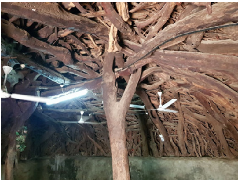
Figure 53. Central columns, cross beam, and roof structure resting on a stone wall (plastered) [Централни ступци, попречна греда, и кровна конструкција која се ослања на камени зид (омалтерисан)]
