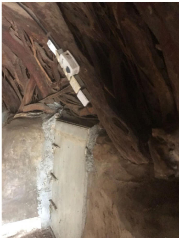
Figure 45. Entrance door to the house, wall and roof structure [Улазна врата у кућу, зид и кровна конструкција]
