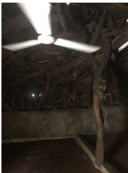
Figure 44. A section of the wall that was later plastered, a roof structure, a column and a beam. A beam that holds the column in place can be seen in the floor [Део зида који је накадно омалтерисан, кровна конструкција, стубац и греда. У поду се види греда која држи стубац у ослонцу]
