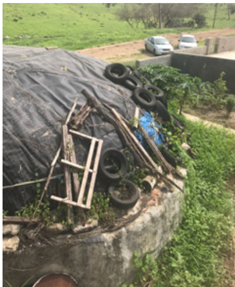
Figure 47. The extensive stone wall of the house (plastered), and the roof cap (covered with foil and pressed with a net, old car tires tied with ropes) [Обимни камени зид куће (омалтерисан), и калота крова (покривена фолијом и притиснута мрежом, старим аутомобилским гумама повезаним конопцима)]
