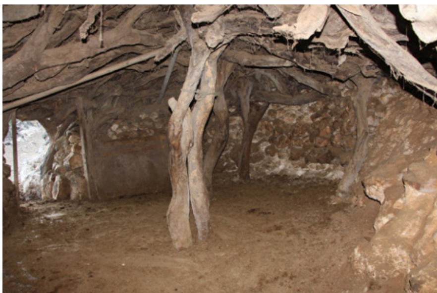
Figure 56. Double columns with ridgepoles at the top, horizontal wooden beams, massive branches of the hipped roof rafters and a stone wall with an entrance door [Удвојени ступци са ракљама у врху, хоризонталне дрвене греде, масивне гране куместо рогова крова и камени зид са улазним вратима]
