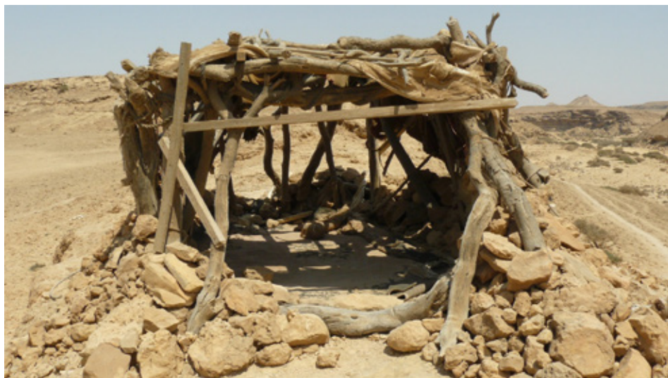
Figure 17. The covered part of the house has a stone wall about 1 meter high. The roof structure is formed by wooden posts that support horizontal beams. A structure made of massive branches rests on them, and then the roof covering [Покривени део куће има камени зид висине око 1 метар. Кровну конструкцију формирају дрвени ступци који носе хоризонталне греде. На њих је наслоњена конструкција од масивних грана и потом кровни покривач]
