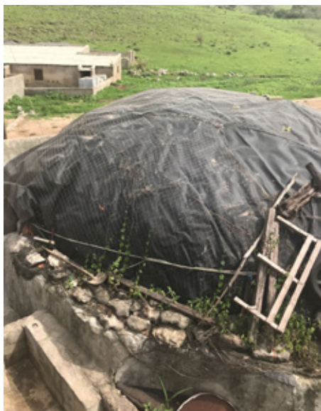
Figure 48. The extensive stone wall of the house (plastered), and the roof cap (covered with foil and pressed with a net, old car tires tied with ropes) [Обимни камени зид куће (омалтерисан), и калота крова (покривена фолијом и притиснута мрежом, старим аутомобилским гумама повезаним конопцима)]
