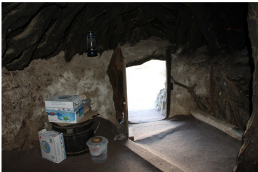
Figure 28. Entrance door to the lobby. Beneath the floor covering, a floor beam can be seen that supports the columns that support the roof structure [Улазна врата према предворју. Испод подног покривача назире се подна греда која учвршћује ступце који носе кровну конструкцију]
